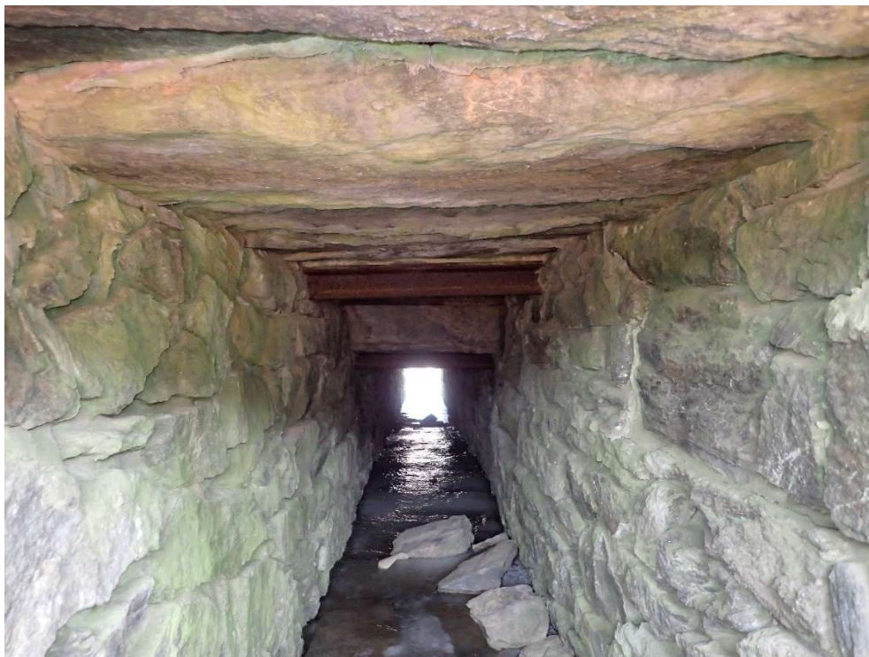
Foto 3: Propustek vyztužený zkorodovanými kolejnicemi
